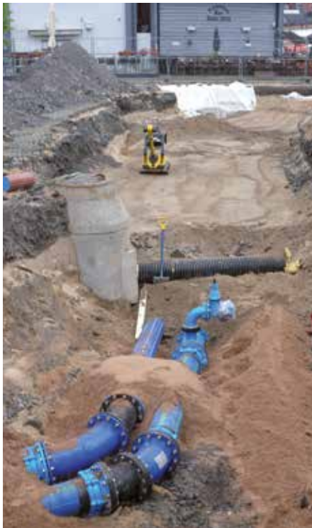
Kivisydämen johtosiirtoja rakennetaan Torinrannassa kesällä 2012.
